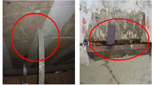
탄소섬유의 박리 (손쉽게 떨어지는 탄소섬유) 강판의 박리 (박리된 강판에 자가 삽입된 모습) Photo 1 탄소섬유와 강판의 박리 사진
