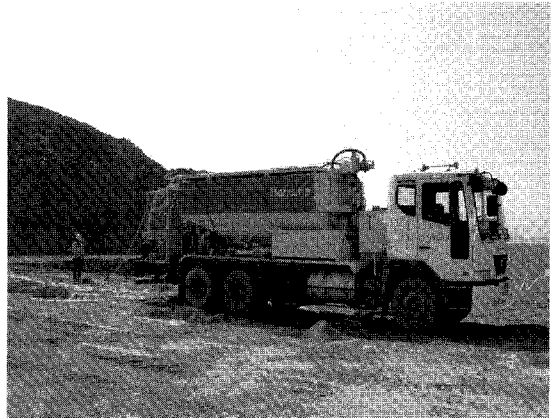
그림 3. gassing 숙련자에 의한 작업 전경.
