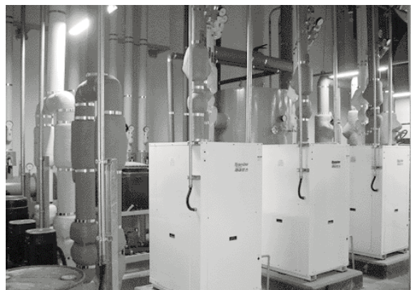
[그림 10] 기계실 연결배관 설치 및 지열 자동제어 판넬
