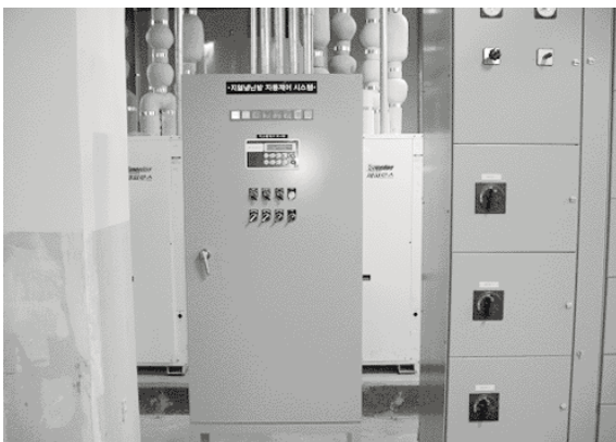
[그림 10] 기계실 연결배관 설치 및 지열 자동제어 판넬
