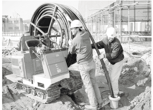
[그림 6] 지열 열교환기 및 설치
