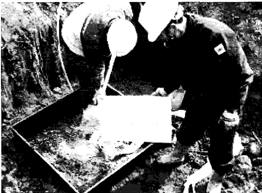
그림 8. 평림댐 수몰지 관정폐공 처리 전경
