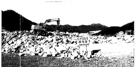
그림 7. 평림댐 수몰지 페콘크리트 재활용 처리 전경
