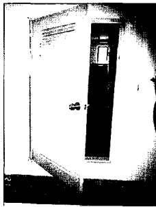
[그림 13] 환기그릴형 출입문 형태 및 차음효과
