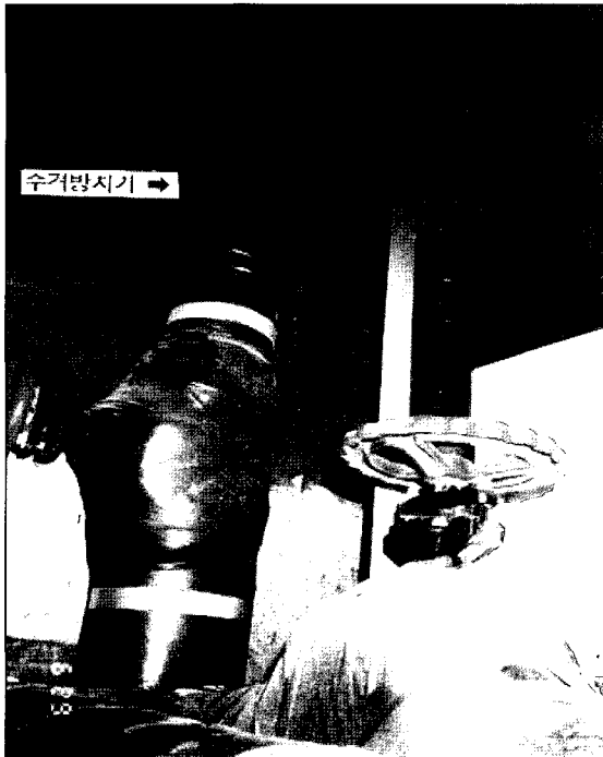
[그림 2] 물탱크 급수배관 워터해머쿠션 및 전자개폐밸브 교체부위
