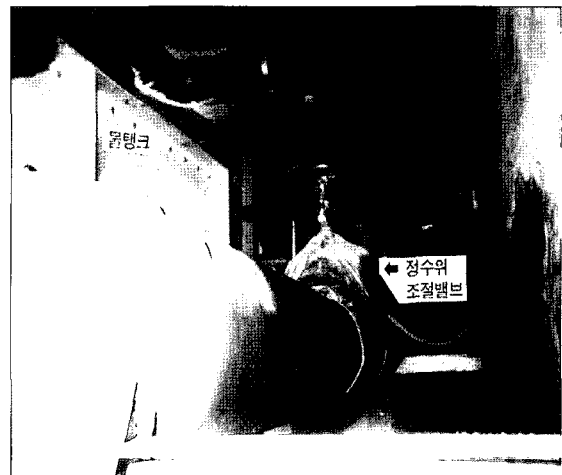
[그림 2] 물탱크 급수배관 워터해머쿠션 및 전자개폐밸브 교체부위
