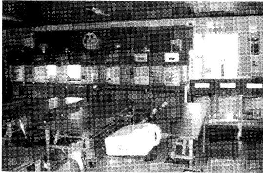
수위계, 우량계 설치 전경
