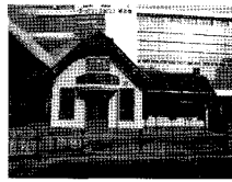
Fig. 13. after construction (대연건축 제공 공사후 사진)
