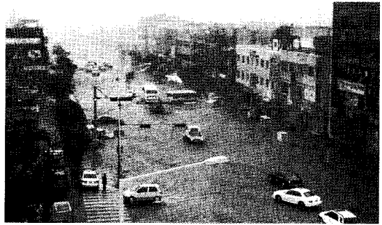
병문천 상가 및 주택가 침수
