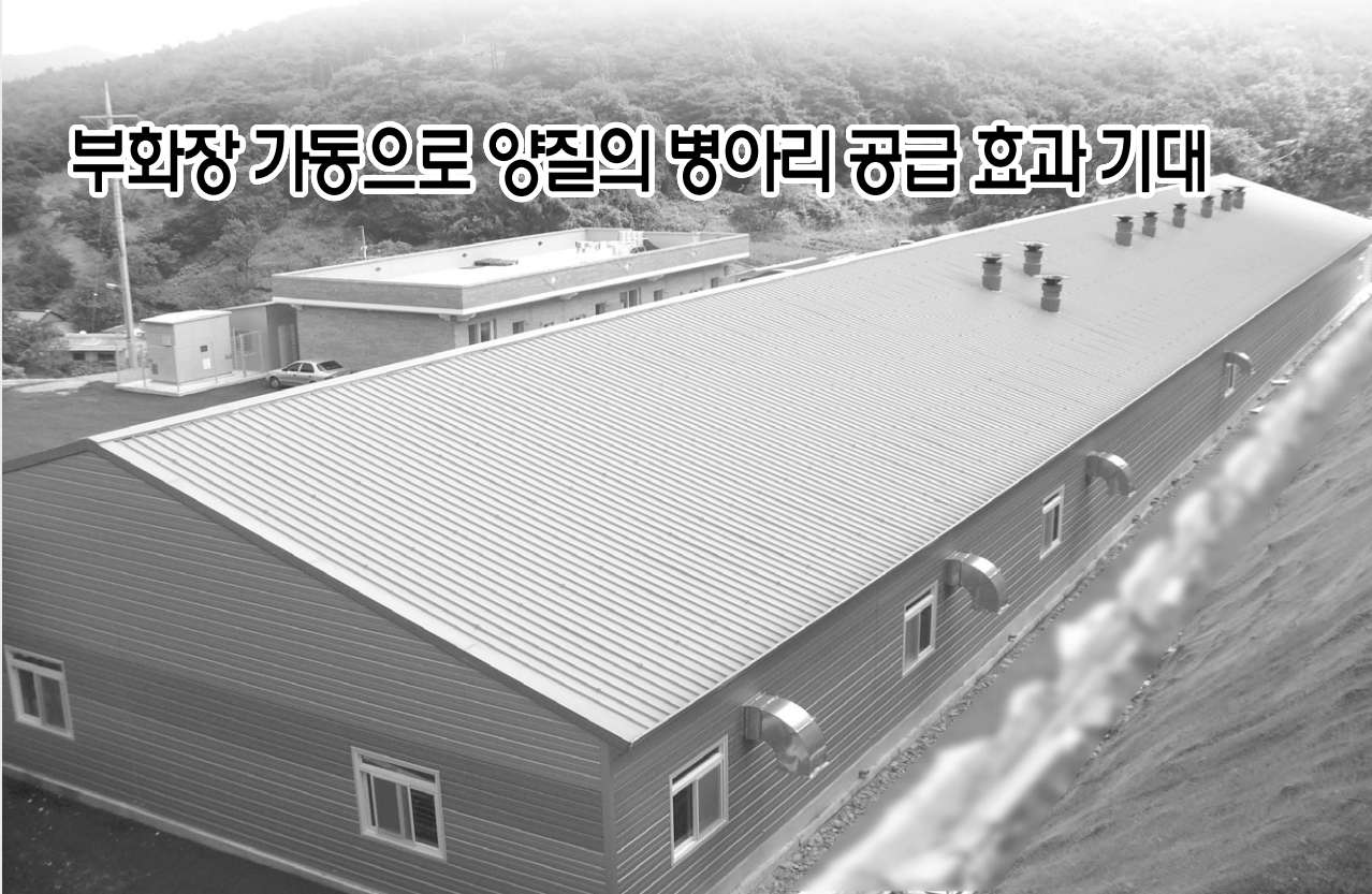
▲보령시 천북면 오포리에 건립된 부화장 전경
