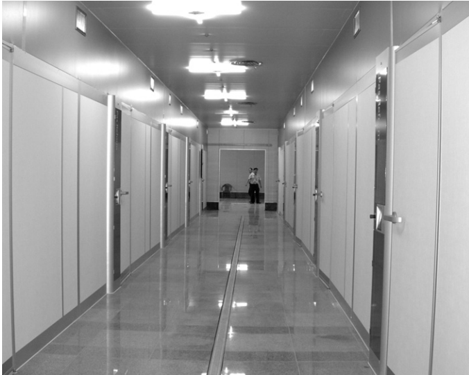
▲네덜란드 르폼부화기가 설치된 부화장 내부전경
