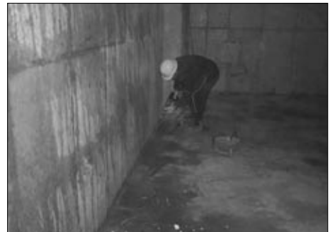
지하층 옹벽 방수작업
