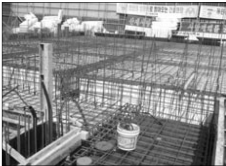
지상 3층 바닥 철근 배근
