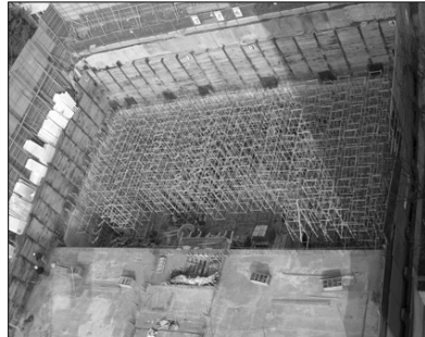
다목적실 시스템거푸집 설치
