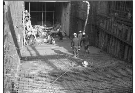
지하주차장 진입램프 콘크리트타설
