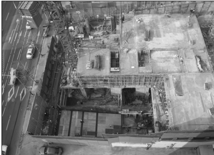
지상1층 바닥슬라브 콘크리트 타설완료
