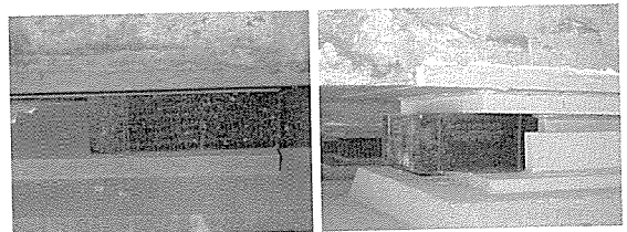
[그림 13]. PSC 빔교의 탄성패드이탈 [그림 14]. ST. BOX교 탄성패드이탈
