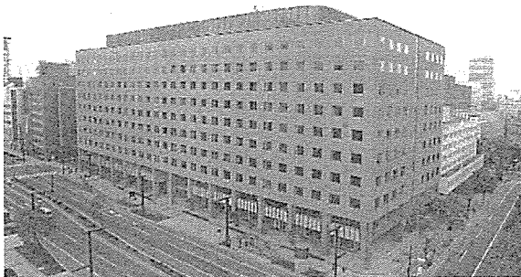
[그림-1] 아반넷트札幌빌딩
