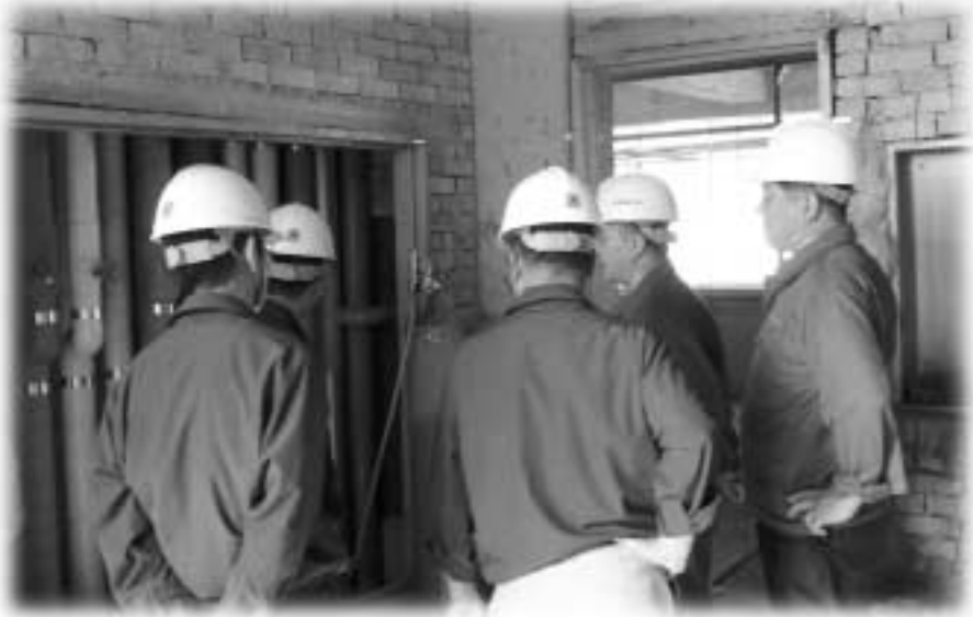
▶ (주)성진플랜트가 시공 중인 운동초등학교 교사 신축공사 현장을 시공품질점검위원들이 꼼꼼하게 체크하고 있다.
