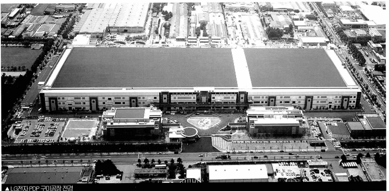
▲ LG전자 PDP 구미공장 전경
