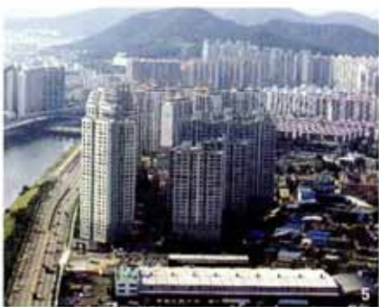
1 해운대 센텀시티 일대에는 초고층 주상복합 아파트 건설 붐이 일고 있다. 2 대구 수성구 범어네거리 일대 전경. 3 부산 센텀시티파크 아파트 단지 내에서 여유롭게 휴식을 취하는 입주주민. 4 지상에는 주차 공간이 없어 공원처럼 땅 몇 위어다닐 수 있는 센텀파크시티 단지 내 모습. 5 부산 센텀시티파크 근처 아파트 공사 현장
