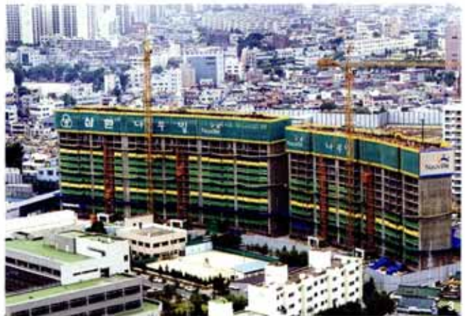
1 대구 수성구 범어네거리 주변에는 아파트 건설 현장이 많다. 2 부산 해운대구 인근에는 새로 지은 고층 주상복합 건물과 모델하우스들이 대거 자리잡고 있다. 3 대구 수성구 범어네거리 주변의 아파트 건설 공사 현장.
