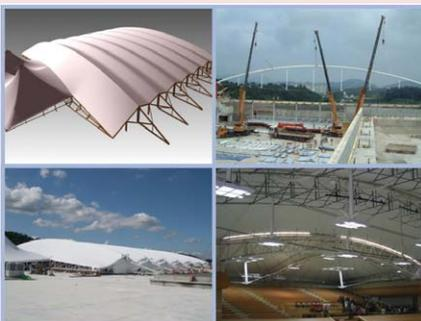
이 구조물은 충청북도 옥천에 위치한 건축면적 21283m<sup>2</sup> 규모의 집회시설로 당초에 있는 콘크리트 슬래브와 기둥을 제거하고, 언더텐션 구조와 막구조로 구성된 장스팬 지붕으로 리모델링된 것이다. 언더텐션 트러스 구조를 적용함으로써 64m의 장스팬 지붕구조를 가능케 하였으며, 케이블과 막재에 프리스트레스를 도입하여 어떤 경우에도 압축력이 발생하지 않도록 하였다. 또한 안정화 이행과정해석을 수행하여 시공중 불안전성을 사전에 고려하는 시공계획을 수립하였으며, 구조감리를 통하여 현장에서 구조설계자와 시공자가 상호 협력함으로써 기술력을 극대화하였고 구조와 시공면에서 합리적인 구조물을 완성하였다.
