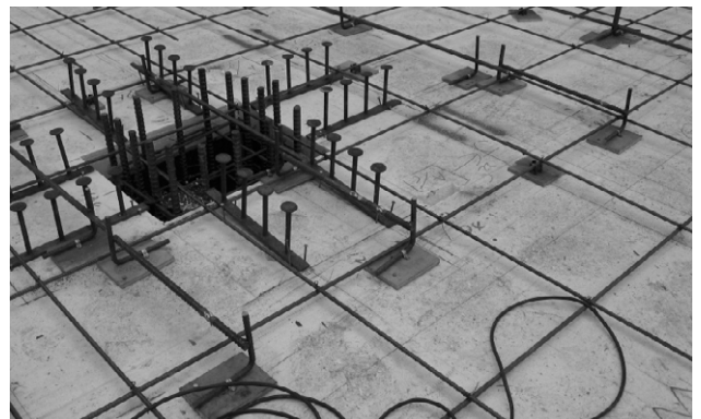
〈사진3〉 스티드 레일 설치
