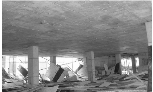
〈사진6〉2층 바닥 모습
