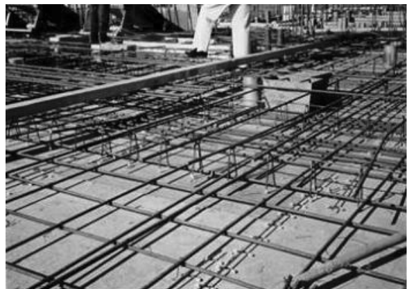
〈그림 3〉 연속 스페이서를 이용하여 상부철근을 고정한 외국의 사례
