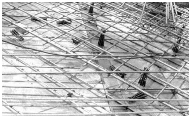
〈그림 2〉 전도가 용이하여 불안정한 단품형태의 플라스틱 스페이서
