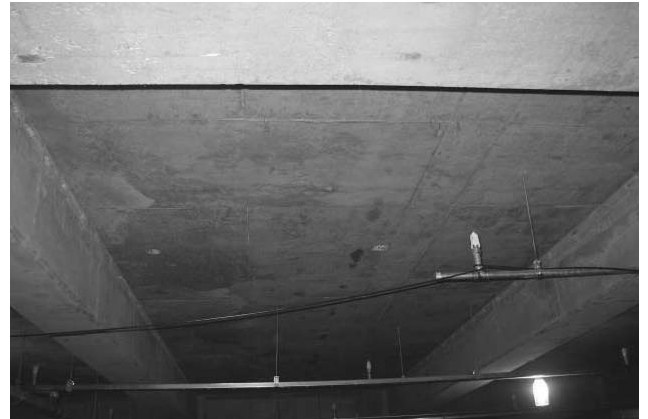
<그림5> 마감공사 전 골조의 표면 상태
