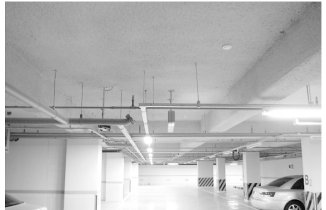
<그림6> 뽕칠마감 후 사용 상태에서의 표면 상태
