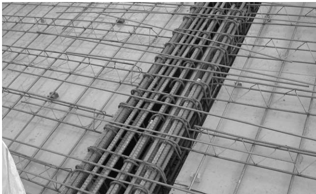
상부 연결 철근의 시공
