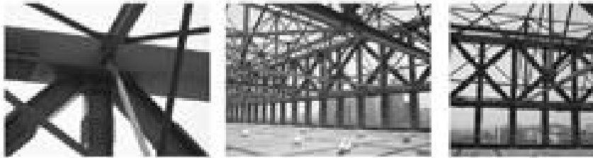
TRUSS 부분 사진
