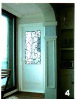
1 확장공사를 해 파우더룸과 휴식공간을 만든 사례 2 거실베란다를 확장하고 샷시로 이중창을 설치한 다음 원목으로 꾸민 사례. 베란다 바닥을 높이고 한쪽에는 미니데크 설치 3 작은방 베란드를 확장하고 2층으로 나누어 놀이공간과 침실공간을 함께한 사례 4 베란다 중문과 거실의 내력벽을 철거 못하는 경우에는 이런식으로 기둥을 장식한다.
