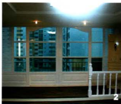
1 확장공사를 해 파우더룸과 휴식공간을 만든 사례 2 거실베란다를 확장하고 샷시로 이중창을 설치한 다음 원목으로 꾸민 사례. 베란다 바닥을 높이고 한쪽에는 미니데크 설치 3 작은방 베란드를 확장하고 2층으로 나누어 놀이공간과 침실공간을 함께한 사례 4 베란다 중문과 거실의 내력벽을 철거 못하는 경우에는 이런식으로 기둥을 장식한다.
