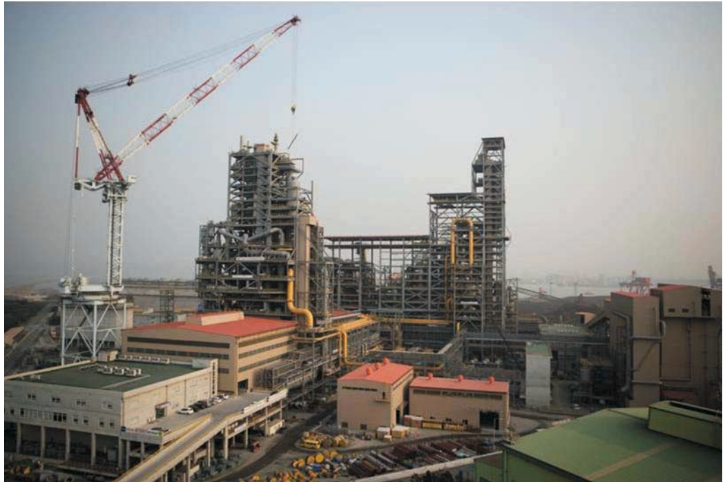
연산 150만톤FINEX 2호기 건설 현장
