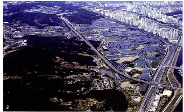
1 판교신도시 공사 이전 모습. 2 판교신도시 항공 사진.
