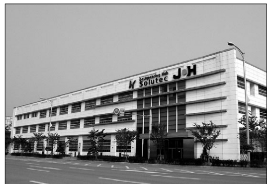
▶재영솔루텍 사옥 전경
