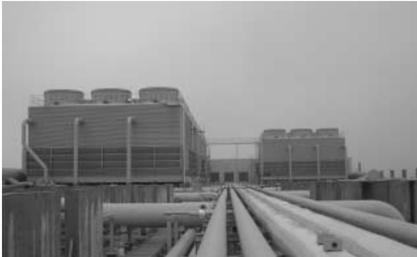
[중국 WUXI 하이닉스 반도체 공장 Roof 냉각탑 배관공사]
