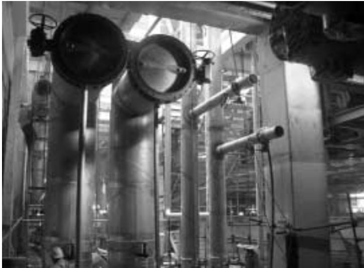
[중국 WUXI 하이닉스 반도체 공장 300m Fabrication 공조기용 배관공사]
