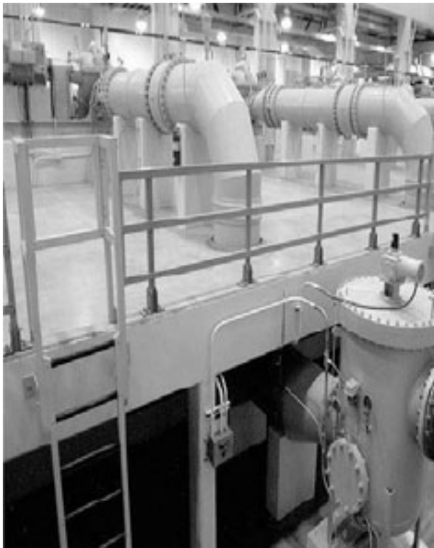
2005년 12월에 가동을 시작한 미네아폴리스 상수도사업소 정수장에 있는 막 공급 펌프는 40개의 한외 여과 막 장치로 구성되어 있으며, 다시 각 장치는 28개의 유리 섬유 압력 용기로 구성되어 있습니다.
