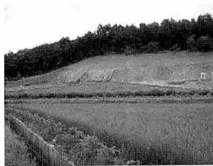
j. 시공 후 전경
