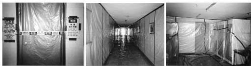
(a)개구부봉쇄(실외쪽) (b)복도벽·바닥 비닐 설치 (c)실내 벽체 비닐 설치
