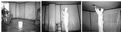
(d)실내바닥 비닐 설치 (e)침투제 분사 (f)천정의 석면마감재 해체
