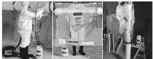
(a)비닐밀봉·장갑낭 부착 (b)칼로 보온재 자르기 (c)수직부 해체방법
