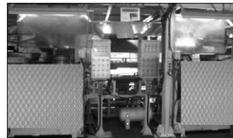
방호울 및 인터록장치 설치
