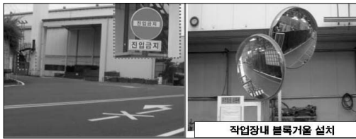
볼록거울 설치 및 통로구획 재조정
