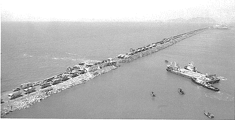
그림 1. 방조제 끝막이 공사 전경
