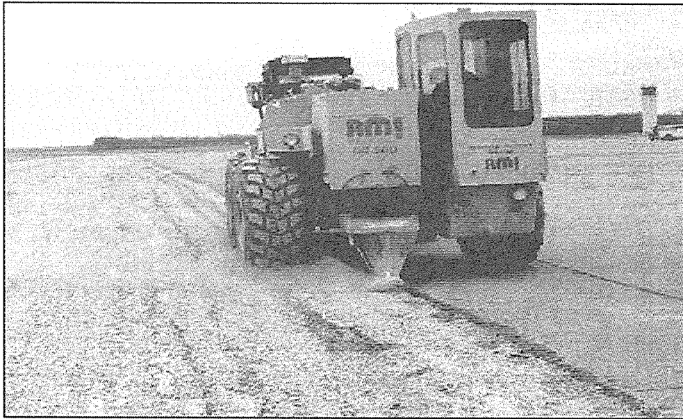
<사진 4> Rubblization Technique
