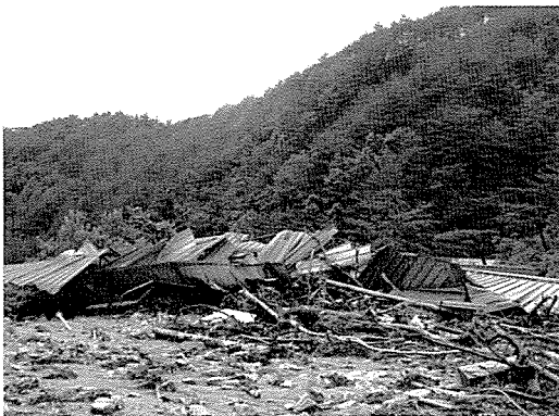
산사태로 완전히 무너져 내린 창고-김정수 분회장 양봉장
