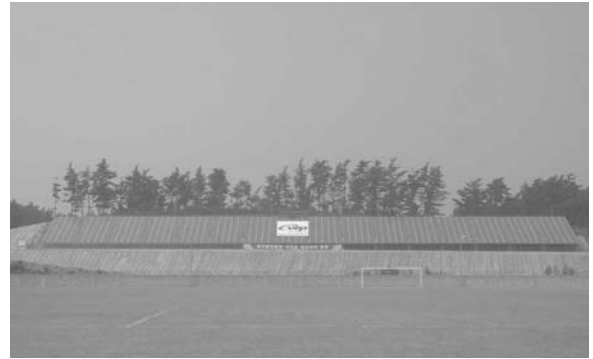
(그림 1-1) 태안 태양광 발전설비 전경(120kWp)
