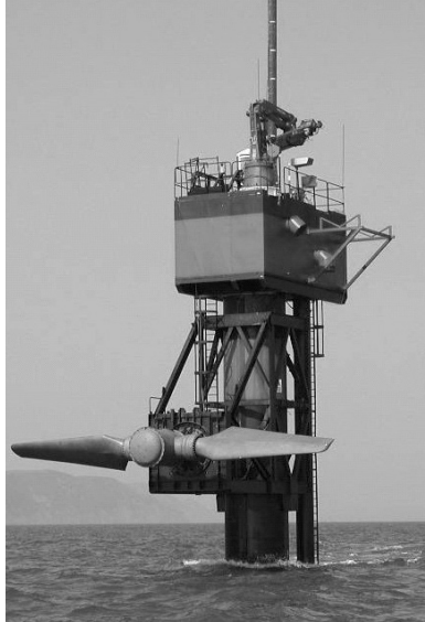
사진 5. MC 조류발전시스템(좌: 모식도, 우: 설치전경)
