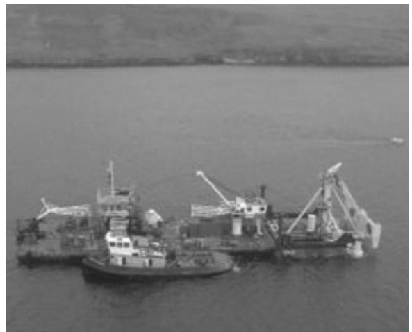
사진 4. Stingray 형 조류에너지 취득 장치(좌: 모식도, 우: 설치전경)
