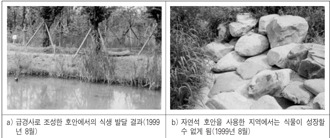
〈그림 3〉 바람직하지 않은 호안 경사와 재료의 처리 결과
