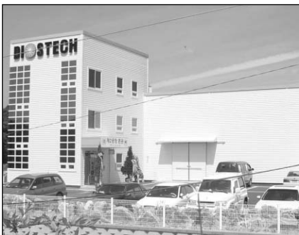
▶경기도 용인에 위치한, 월 250만 개의 렌즈 모듈 생산 능력을 갖춘 디오스텍 제2공장 전경
