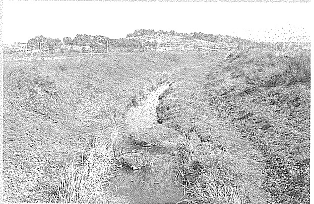
영광천 시공 후 전경(생태블록3형)
