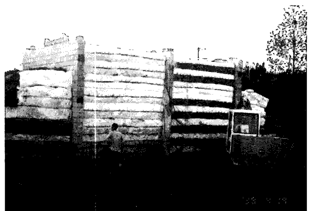
그림 6. 보강토옹벽 구축 직후의 전경사진
