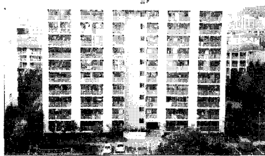
사진 1. 영구임대주택 주동 전경
