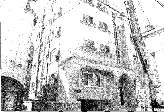
Fig. 화재현장 건물 전경
