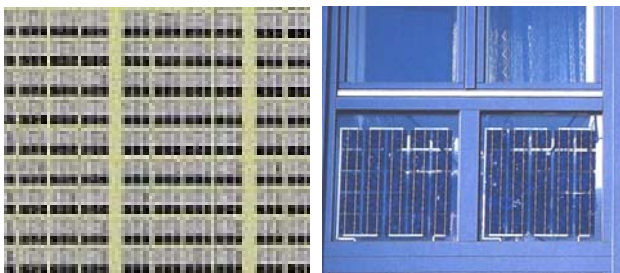
그림 11. 창호용 BIPV적용 예(시뮬레이션), 외국의 실적용 예
