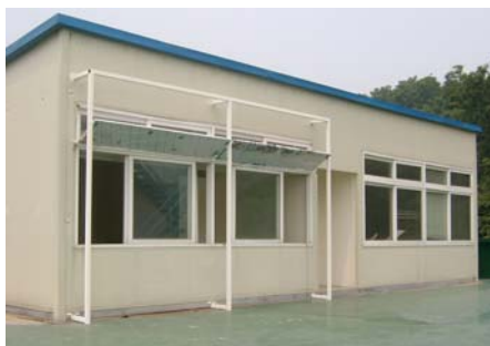
그림 6. 광선반시스템의 설계 및 설치
