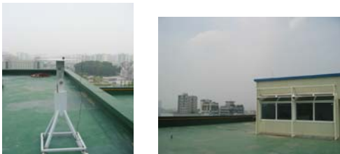
그림 15. 옥외 수평면조도 측정센서 설치 모습 및 천공상태
