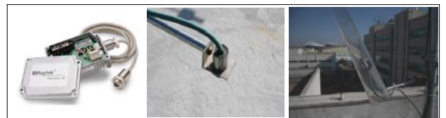
그림 15. 적외선 온도측정장치 및 실험구 설치모습
