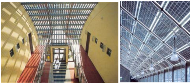
그림 11. 채광 및 차양기능의 G/G모듈 적용 대형유리 지붕 예
