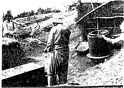
그림 11. 부석사 보수공사 보충 瓦제작장면 (출처 : 杉山信三篇, 『韓國古建築の保存』 1996, 韓國古建築の保存刊行會, .p.53.)
