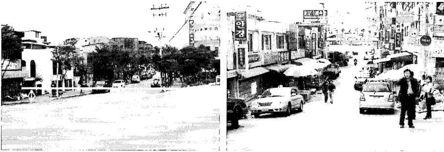
그림 1.1 덕풍지구 상습침수지구 저지대 전경
