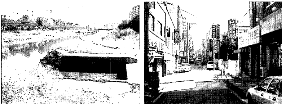
그림 4.1 연산 9동 침수지구내 복개하천인 한양천 출구 및 침수발생지역
