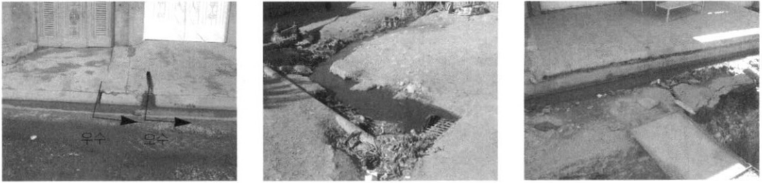
Fig. 3. 일반 가정오수의 지표유출로 악취 및 보건위생 문제 발생
