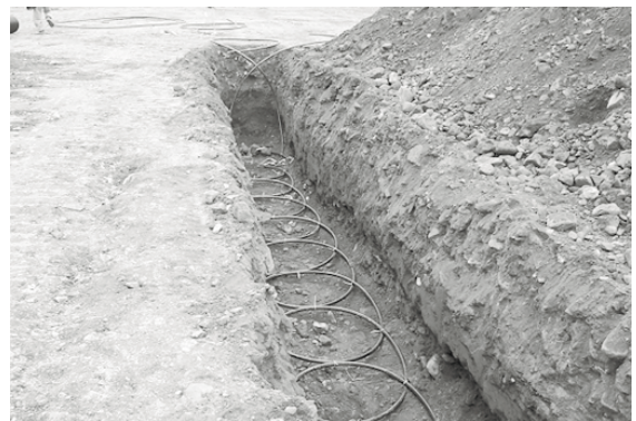
[그림 2] 슬링키 지중열교환기 시공 모습
