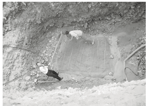
[그림 9] 지중열교환기 설치
