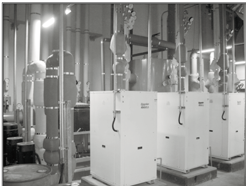
<그림 8> 기계실 연결배관 설치 및 지열 자동제어 판별
