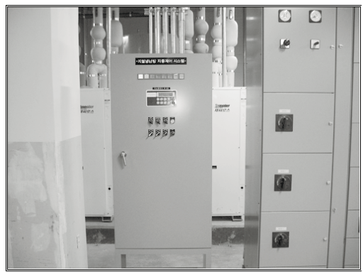
<그림 8> 기계실 연결배관 설치 및 지열 자동제어 판별
