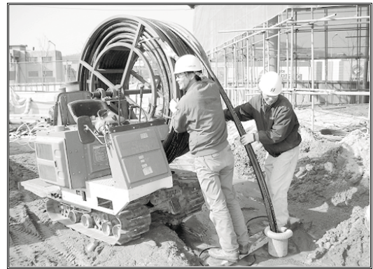
<그림 5> 지열 열교환기 및 설치
