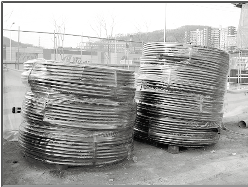
<그림 5> 지열 열교환기 및 설치
